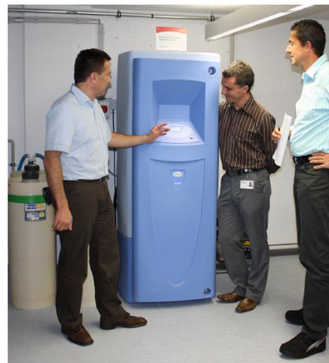
Alle Systemparameter und der Verbrauchsmaterialien-Status werden automatisiert überwacht, zahlreiche Sicherheitsfunktionen garantieren eine zuverlässige Versorgung. Dazu zählen der interne Leckageschutz, der Trockenlaufschutz für die Rezirkulationspumpe und ein Überdruckalarm für die Ringleitung. Im Ernstfall oder bei Wartungen sichert eine interne Notversorgung den störungsfreien Schulungsablauf. Die Steuerungssysteme der Anlage sind durch Zugangskontrollen vor dem Zugriff Unbefugter geschützt.
